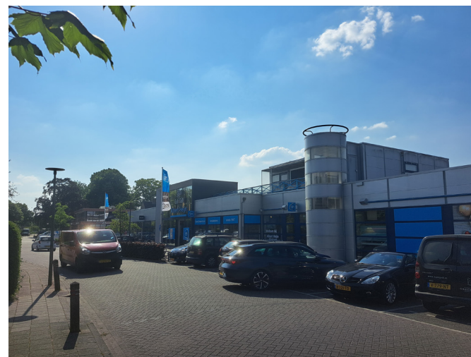
Winkelvoorzieningen aan de Voorstraat
