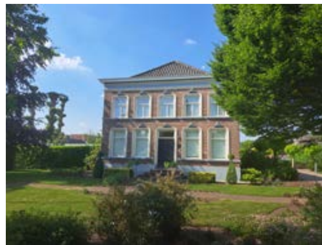
Gemeentelijk monument aan de Voorstraat
