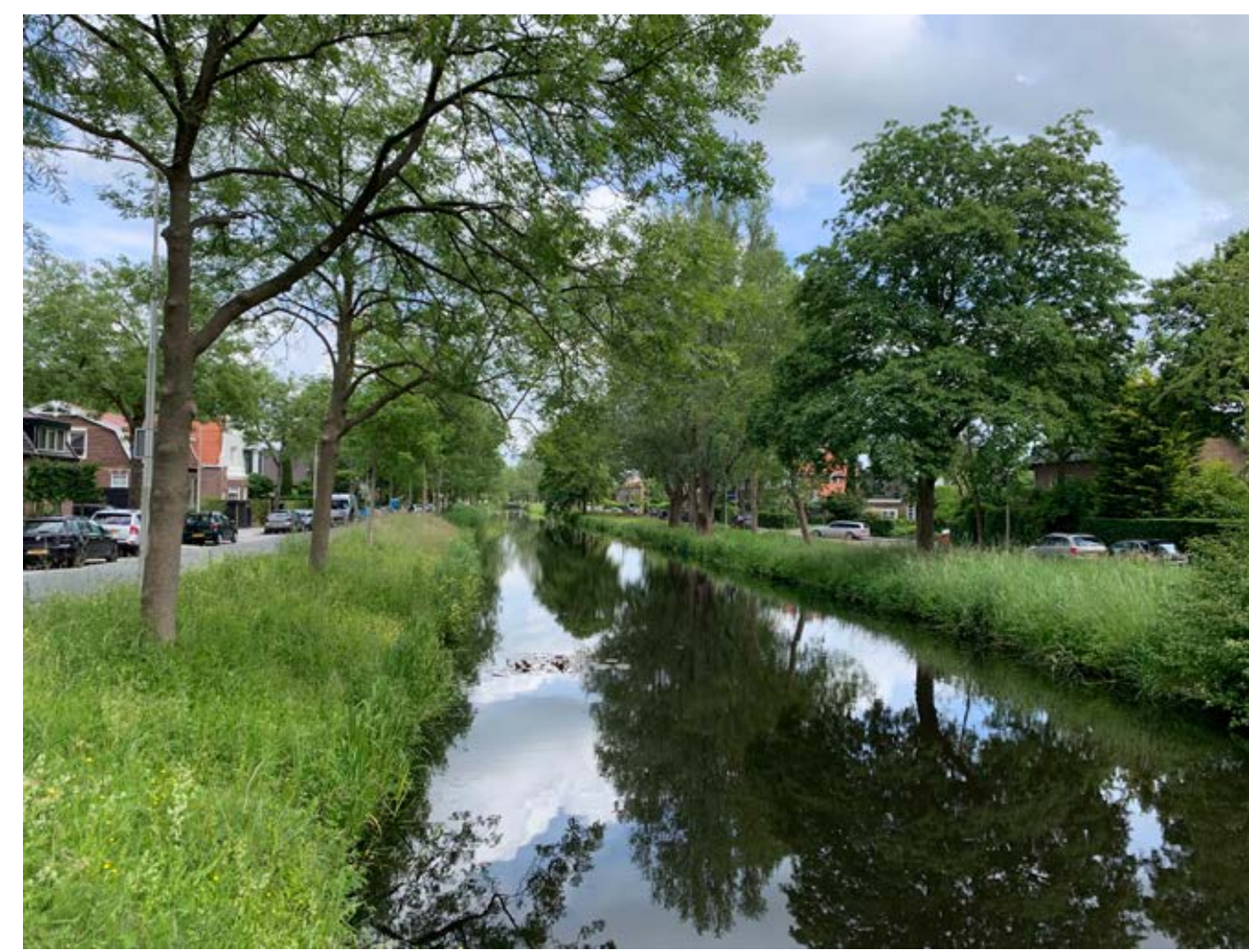
Links een oever met een steiler talud (1:2). Rechts een oever met een flauwere helling (natuurvriendelijk)
